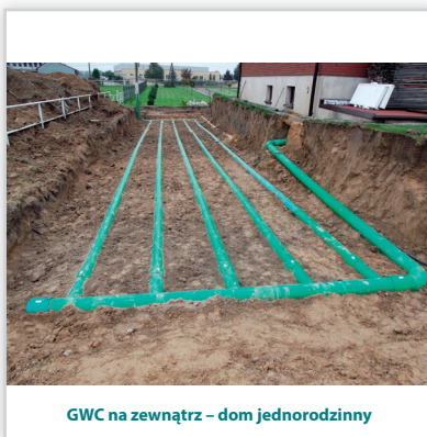
Gruntowy wymiennik ciepła GLOBAL. Wykonany z polietylenu (PE) z warstwą antybakteryjną, antygrzybiczną i antywirusową łączony poprzez zgrzewanie doczołowe lub elektrooporowe, 100% szczelność. Współczynnik przewodzenia [W/mK]: 0,50. Zastosowanie: w wentylacji mechanicznej we współpracy z rekuperatorem, w domach jednorodzinnych, wielorodzinnych, obiektach użyteczności publicznej.
