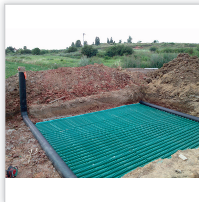
Gruntowy wymiennik ciepła GEOSTRONG – na zewnątrz domu. GWC bezprzeponowy modułowy. Przepływ powietrza turbulentny, wymiana cieplna ze wszystkich stron GWC. Wytrzymałość na nacisk z góry: 460 t/m 2 . Zastosowanie: w wentylacji mechanicznej we współpracy z rekuperatorem w domach jednorodzinnych, wielorodzinnych. Możliwość wykonania GWC o każdej wielkości przepływu powietrza. Możliwość samodzielnego montażu.
