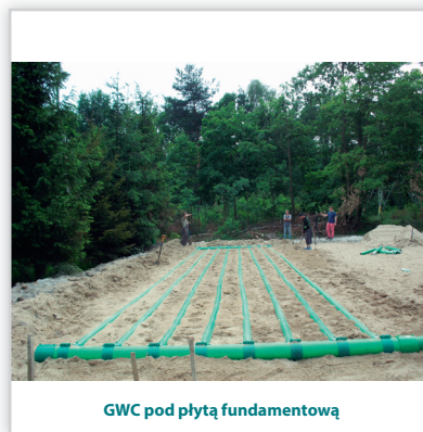
Gruntowy wymiennik ciepła GLOBAL. Wykonany z polietylenu (PE) z warstwą antybakteryjną, antygrzybiczną i antywirusową łączony poprzez zgrzewanie doczołowe lub elektrooporowe, 100% szczelność. Współczynnik przewodzenia [W/mK]: 0,50. Zastosowanie: w wentylacji mechanicznej we współpracy z rekuperatorem, w domach jednorodzinnych, wielorodzinnych, obiektach użyteczności publicznej.
