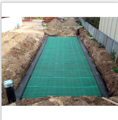
Gruntowy wymiennik ciepła GEOSTRONG – dla hali produkcyjnej. GWC bezprzeponowy modułowy. Przepływ powietrza turbulentny, wymiana cieplna ze wszystkich stron GWC. Wytrzymałość na nacisk z góry: 460 t/m 2 . Zastosowanie: w wentylacji mechanicznej we współpracy z rekuperatorem w obiektach użyteczności publicznej, pawilonach, magazynach, restauracjach. Możliwość wykonania GWC o każdej wielkości przepływu powietrza. Możliwość samodzielnego montażu.
